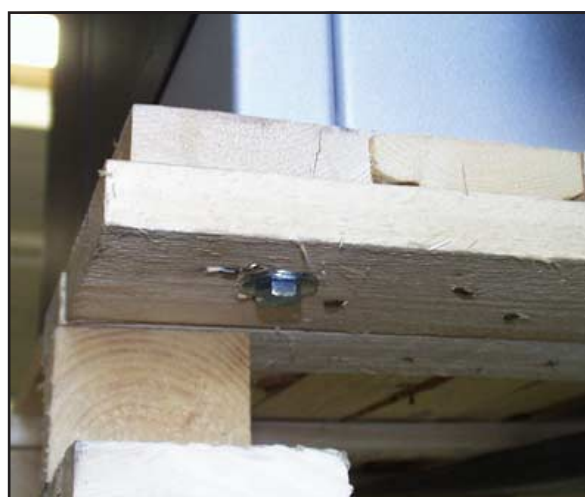
Bild 3-D Verschraubung des Prozessors auf der Palette.
